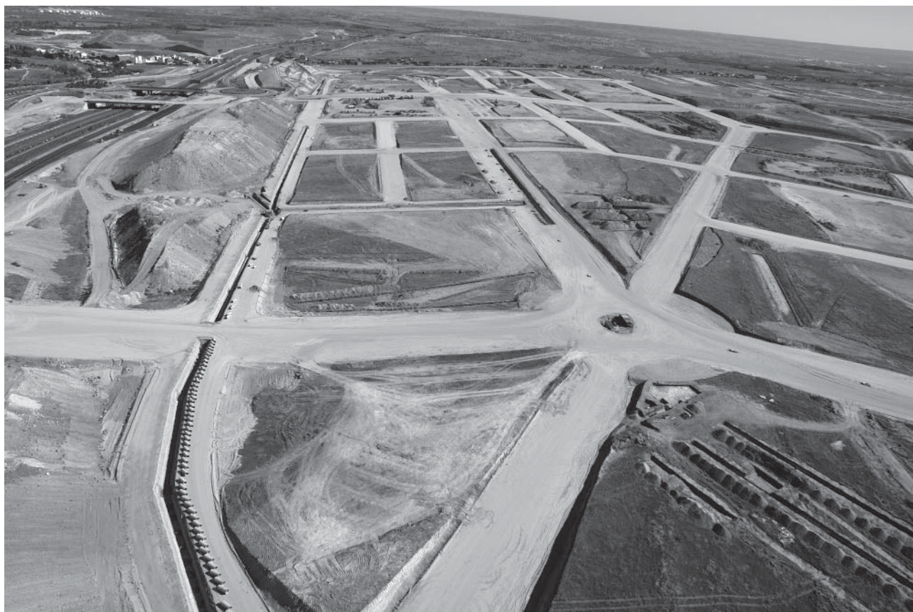
Figure 5. Aerial view of the sondage area and the Parcela 32 excavation (Cortesía of the Junta de Compensación de la UZP2.01 El Cañaveral).
