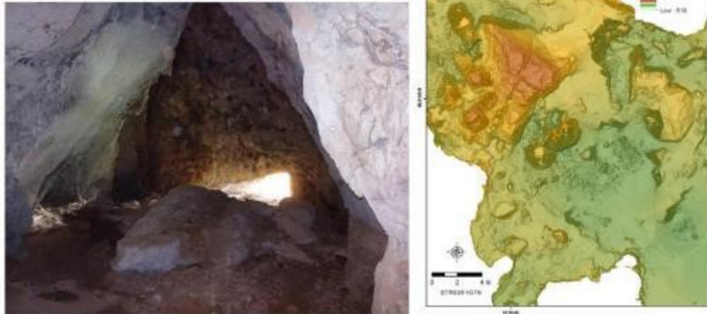
Figura 21.- Vista de la part intermitja de la cavitat de la Cova del Tabac, on destaquen els blocs desplomats del sostre per la presència de un encreuament de fractures.
